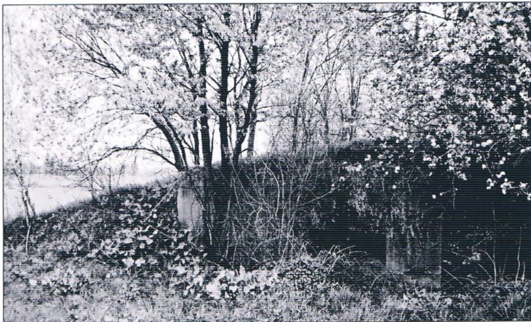
24. Schron dla ckm. Dachnów
