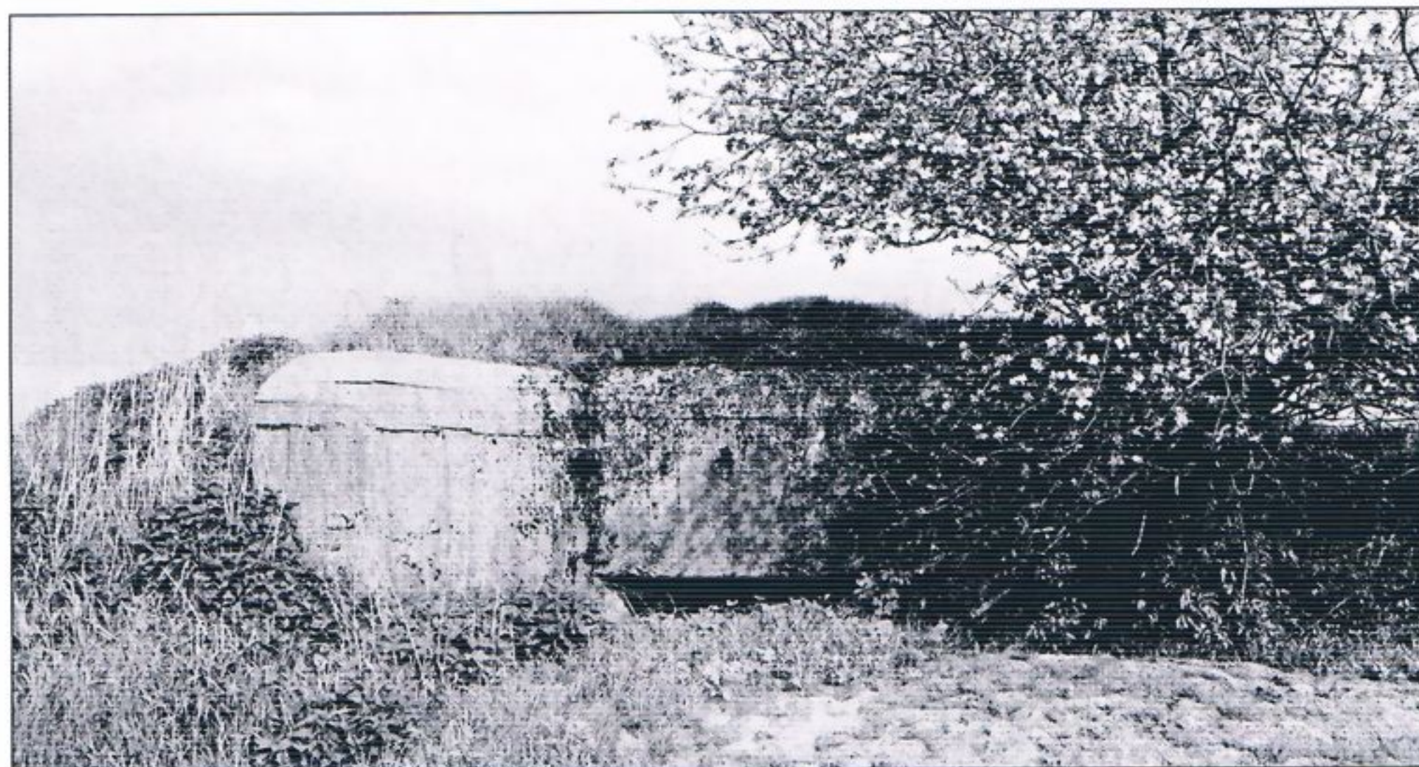
25. Schron dla ckm. Dachnów
