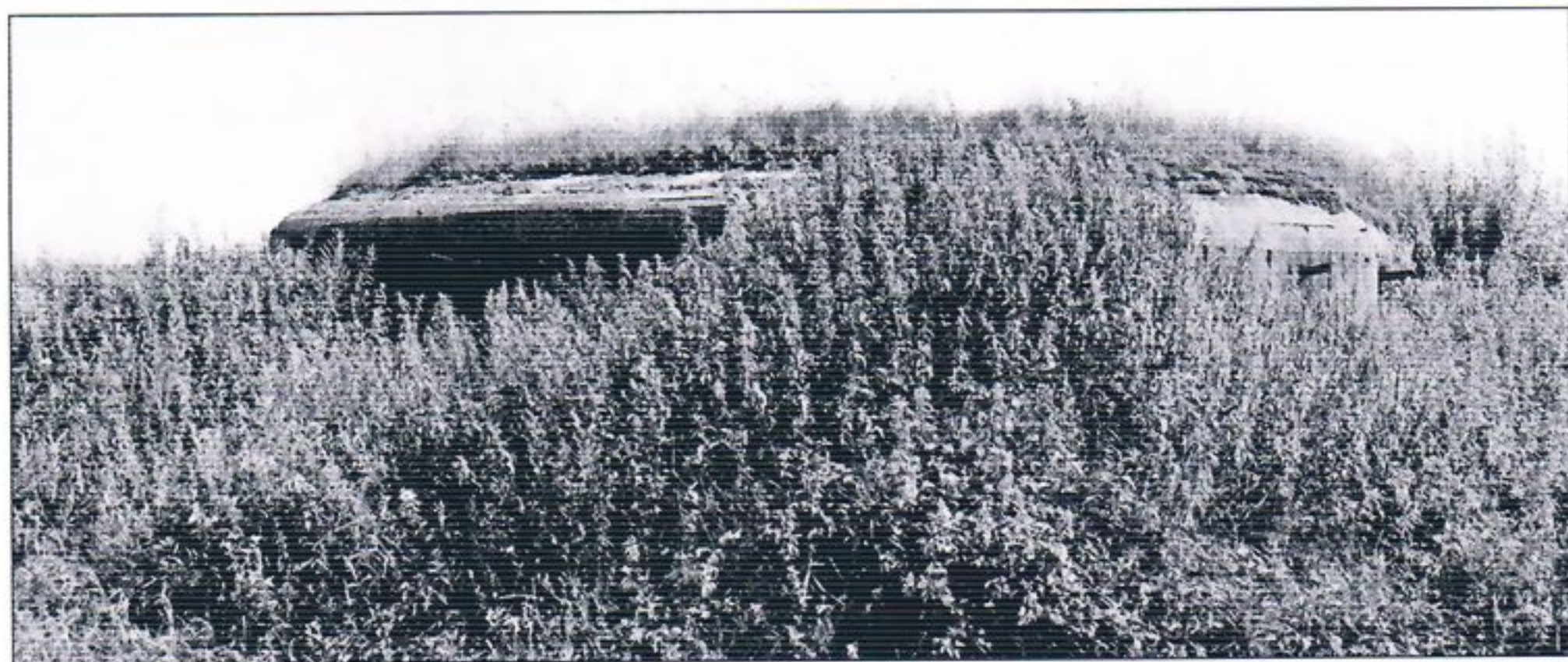
1. Schron do ognia czołowego dla 3 ckm. Punkt oporu Duńkowice
