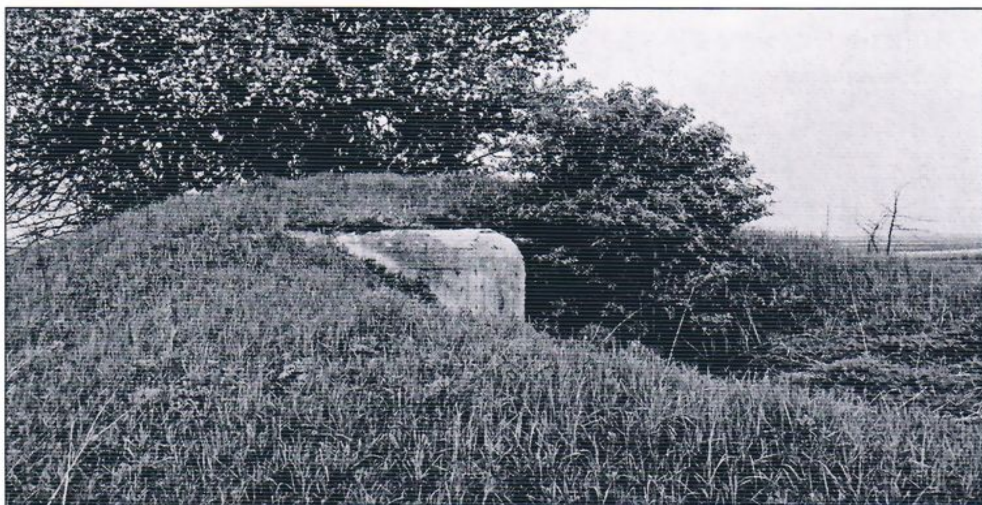
27. Schron dla ckm. Dachnów
